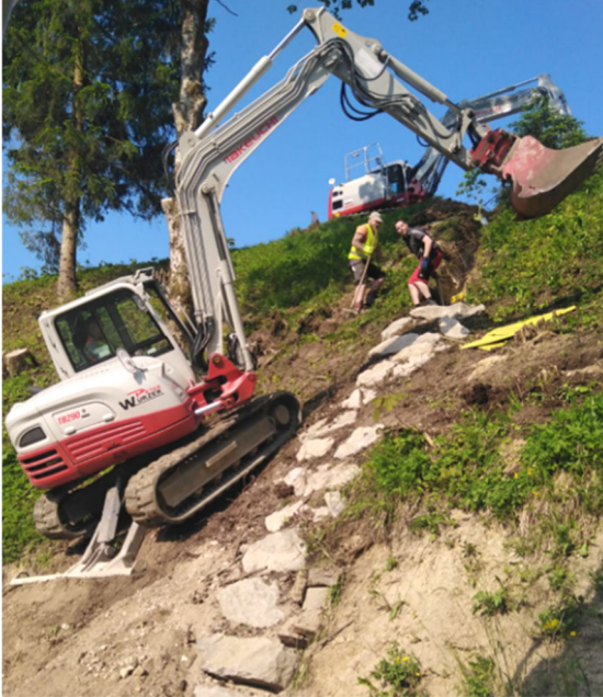
Schwierige Grabarbeiten im Bereich Mausrodl
