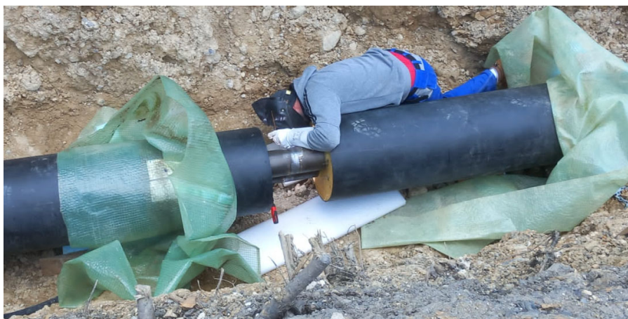
Die isolierten Doppelrohre werden im WIG-Schweißverfahren verschweißt.
