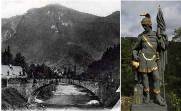
li.: Die Töpferbrücke bei Kasten 1903; re.: Der Heilige Florian ist eine der Brückenfiguren.
